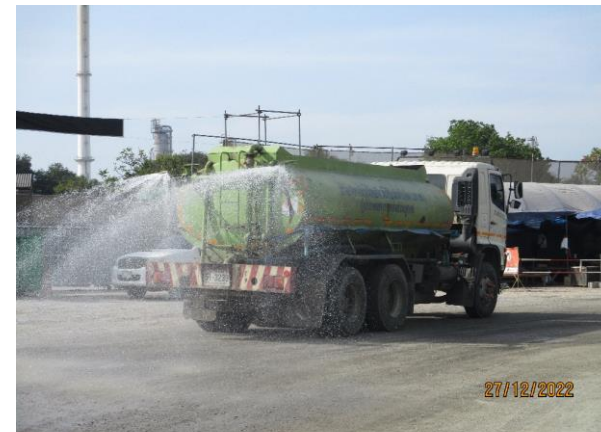
รูปที่ 2-2 การฉีดพรมน้ำป้องกันฝุ่นละออง
