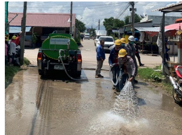
รูปที่ 2-2 การฉีดพรมน้ำป้องกันฝุ่นละออง
